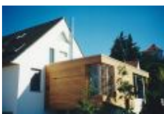
Přístavba RD v Praze realizace 06/1999 - 10/2000
