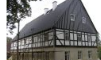
Zámek v Jeseníku realizace 09/2007, kompletní oprava, včetně kontaktního
