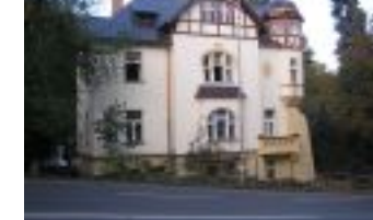
Restaurace bývalé kasárny v Jeníkově ulici, město Jablonec nad Jizerou realizace 05/2007, kompletní rekonstrukce, nové
