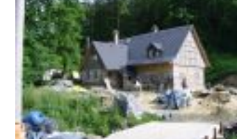
Rekonstrukce chalupy v Mojce realizace 04/2011 - 08/2011, kompletní rekonstrukce
