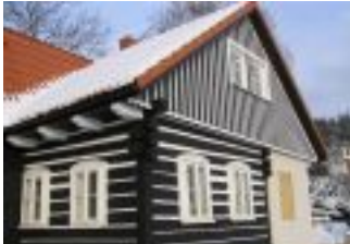
Příhraniční chalupa v Mojce realizace 06/2012 - 12/2012, kompletní přestavba a přístavba
