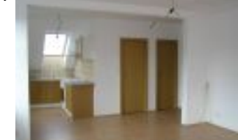
Příhraniční chalupa v Mojce realizace 04/2012 - 12/2012, kompletní přestavba a přístavba
