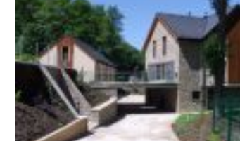
Penzion u Liberce realizace 05/2009 - 05/2011, kompletní rekonstrukce objektů
