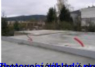
Zhotovení základů a podlahy realizace 09/2012 - 03/2013,
