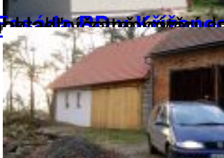
Pokládka střešní krytiny realizace 08/2013, oprava krovu včetně výměny uhnílych trámů a
