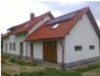
Fasáda rodinného domu v Jezvé realizace 04 - 05/2014, fasáda RD v Jezvé, tepelněizolační omítkou
