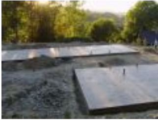
Základy pro rodinný dům Pulečný realizace 08 - 08/2015, základy pro RD Pulečný
