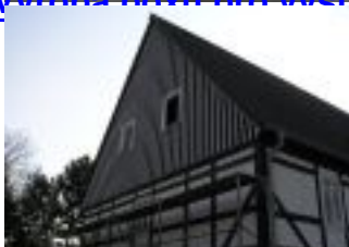
Oprava štítu chalupy realizace 03/2012, oprava štítu chalupy, výměna trámů a
