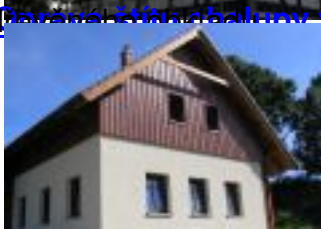
Stavba domu realizace 09/2012 - 03/2014, výměna štítu chalupy, výměna trámů a
