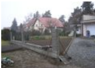
RD v Praze realizace 09/2012 - 03/2014, venkovní úprava kolem
