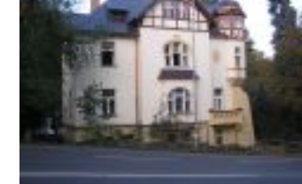
Rekonstrukce objektu v Liberci realizace 05/2007, kompletní rekonstrukce, nové
