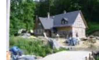
Rekonstrukce chalupy v Nojinku realizace 04/2011 - 08/2011, kompletní rekonstrukce
