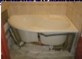
Koupena s burovníkem v veselí realizace 01/2005, kompletní rekonstrukce koupelny a
