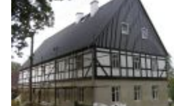
Rekonstrukce objektu v Liberci realizace 09/2007, kompletní oprava, včetně kontaktního
