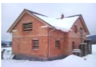
Hrubá stavba RD v Libereci realizace 08/2009
