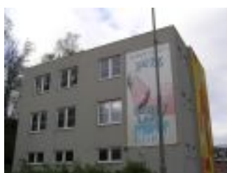
Stavební úpravy - dokončení kanceláří firmy v Liberci realizace 04 - 06/2014, kanceláře firmy v Liberci - stavební úpravy dokončení 1.p.
