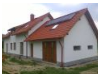
Fasáda rodinného domu v Jezvé realizace 04 - 05/2014, fasáda RD v Jezvé, tepelněizolační omítkou
