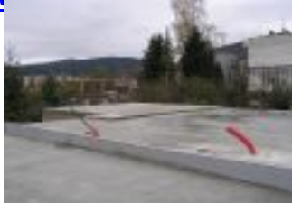
RD v Praze realizace 09/2013 - 03/2014, venkovní úprava kolem
