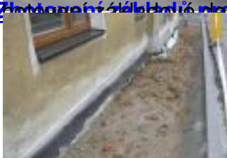
RD v Praze realizace 09/2013 - 03/2014, venkovní úprava kolem
