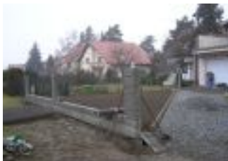
RD v Praze realizace 09/2013 - 03/2014, venkovní úprava kolem
